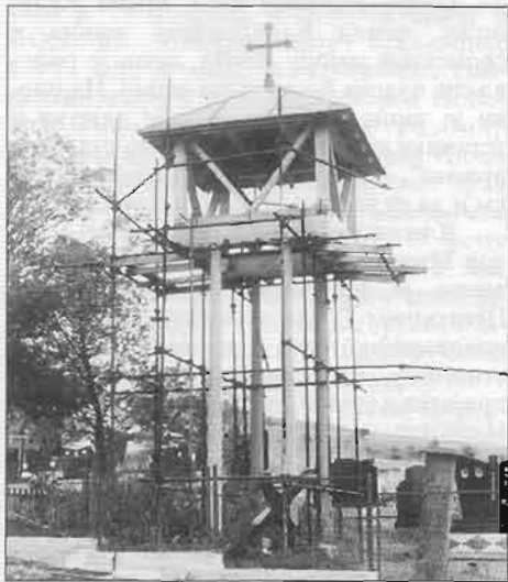
Трајније решење: бетонски стубови звонаре у Буковику
